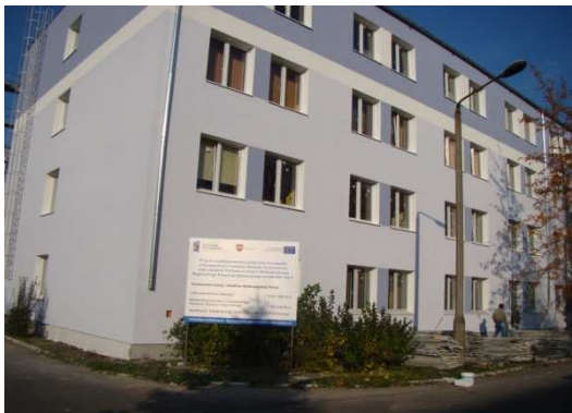
Zdjęcie nr 7 i 8. Budynek OPP w Poznaniu przed oraz po pracach termomodernizacyjnych
