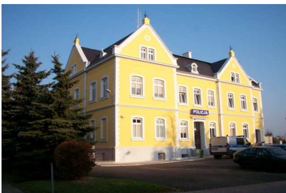
Zdjęcie nr 3 i 4. Budynek KPP w Śremie przed oraz po pracach termomodernizacyjnych
